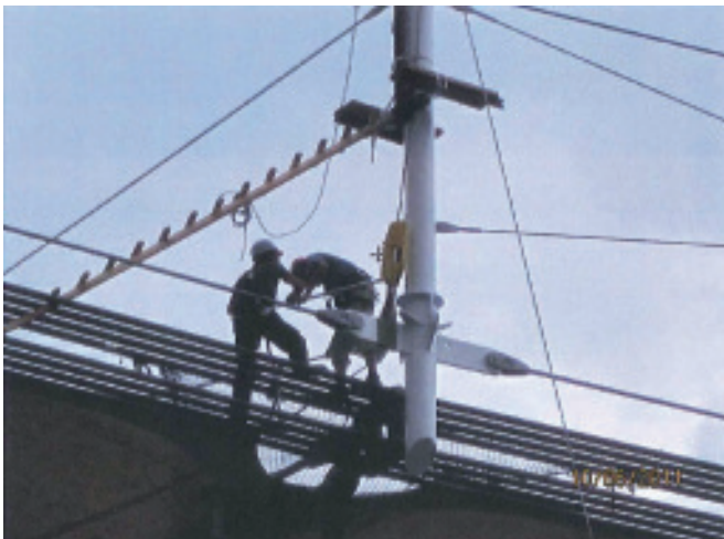
Bild 13. Bedienung des Greifzugs Fig. 13. Handling of the rope jack
