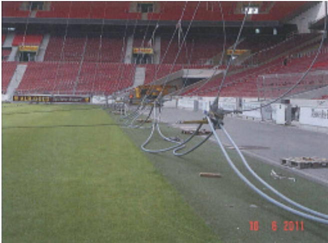
Bild 12. Anheben der Knoten mit Abspannfächer Fig. 12. Initial lift with temporary guys
