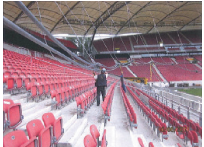
Bild 14. Lösen der Abspannungen Fig. 14. Unlocking the temporary guys
