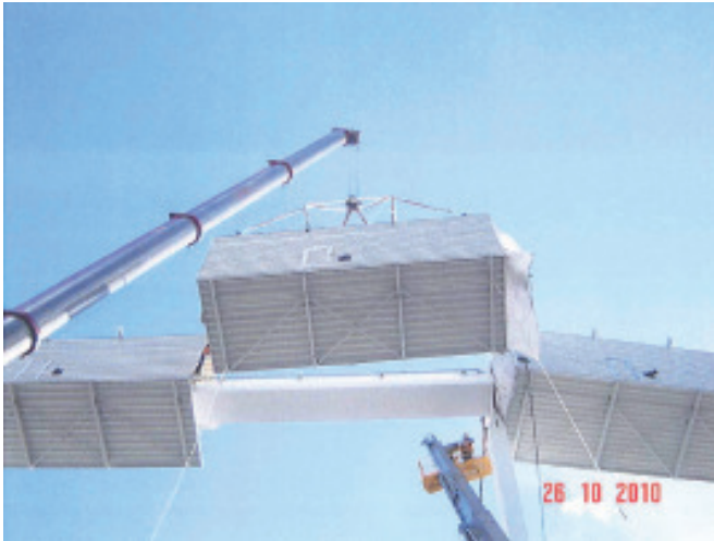
Bild 7. Hub der Einhausung Fig. 7. Lift of the encasement
