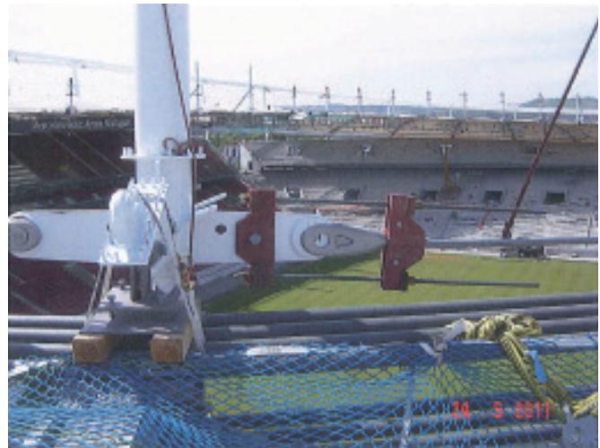
Bild 10. Temporärer Anschluss des unteren Ringseils an eine Luftstütze Fig. 10. Temporary connection between a lower ring cable and a column
