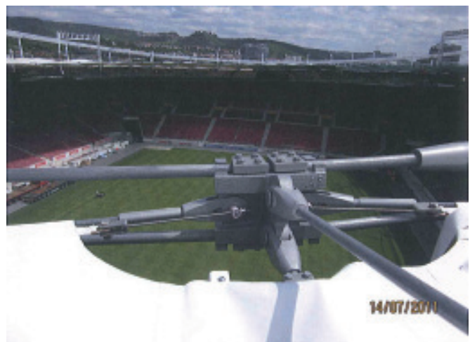
Bild 18. Seilknoten mit Anschluss der Membran Fig. 18. Cable joint with fixed membrane
