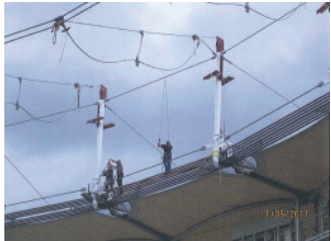
Bild 16. Hubvorgang abgeschlossen, Tragseil bereit zum Einbolzen Fig. 16. Cable net lift finished
