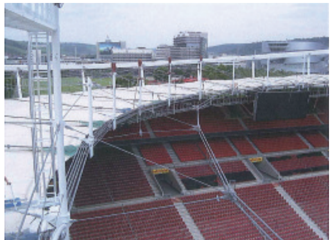
Bild 17. Gespanntes Seiltragwerk Fig. 17. Prestressed cable net
